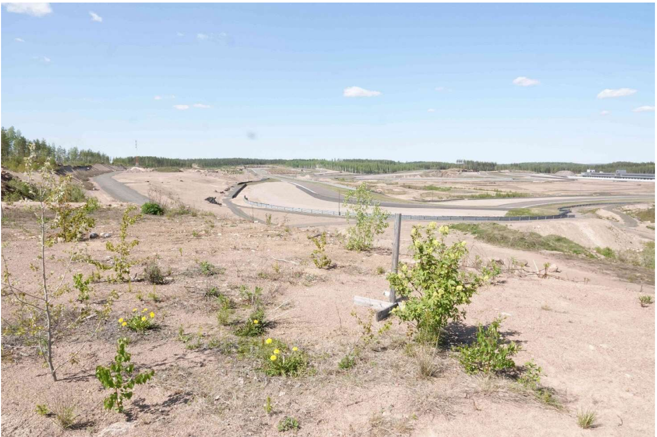
Kuva 1. Näkymä havaintopisteeltä luoteeseen päin moottoriradan yli.
