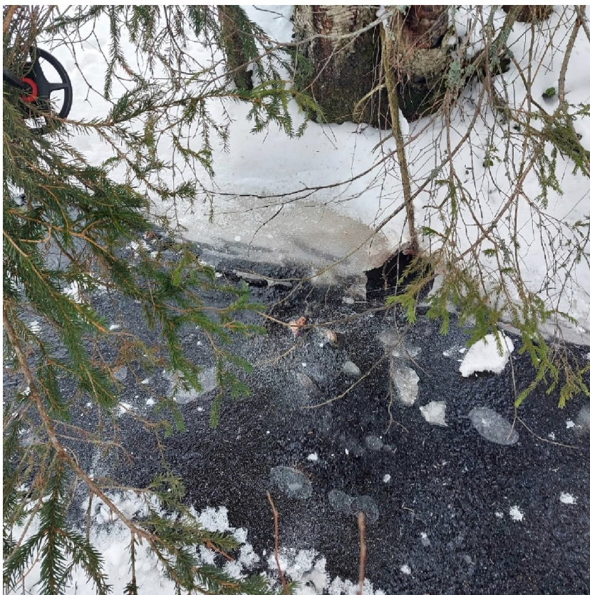
Kuva 11. Tunnelin suu- aukko ja eläinten, to- dennäköisesti sam- makko, jäänteet suu- aukon vieressä.
